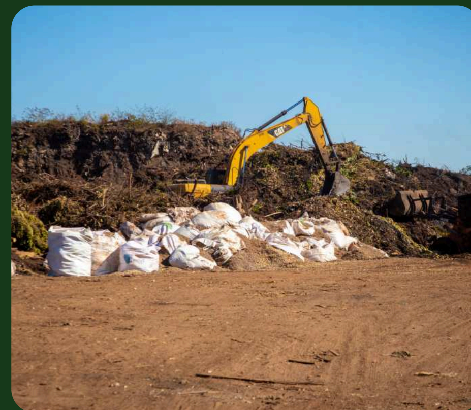
Sistema de monitoramento e controle ambiental
