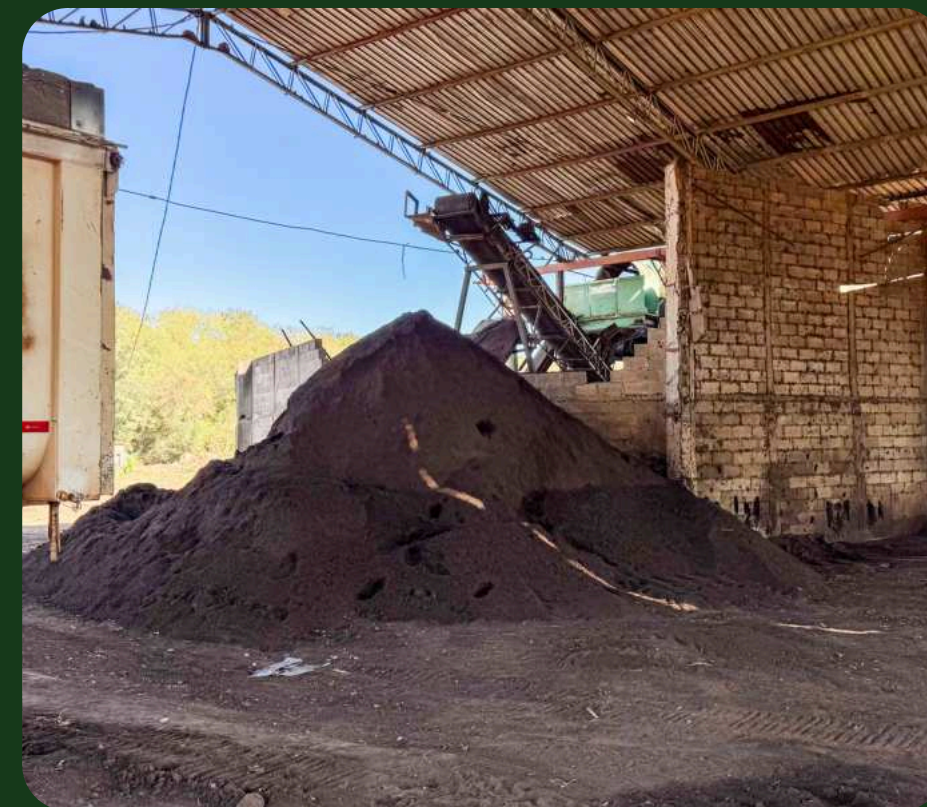
Galpões de triagem e compostagem
